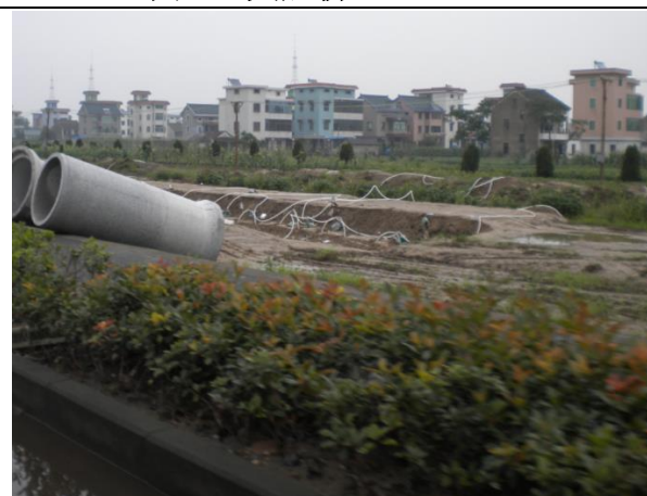
图 1-5 小泗埠横河沿线管线施工（2011.12）
