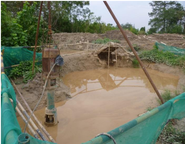
图 2-6 施工期泥浆沉淀池
