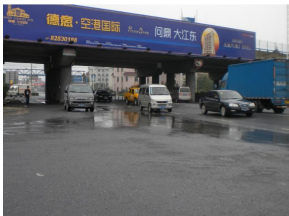
图 1-1 起点段施工前（2011.8）
