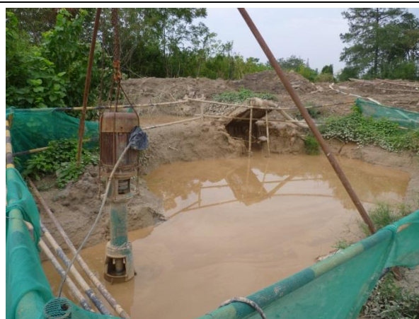
图 1-10 钻渣泥浆沉淀池（2012.5）
