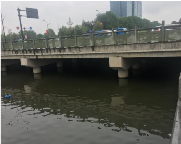
图 2-5 俞家场桥现状
