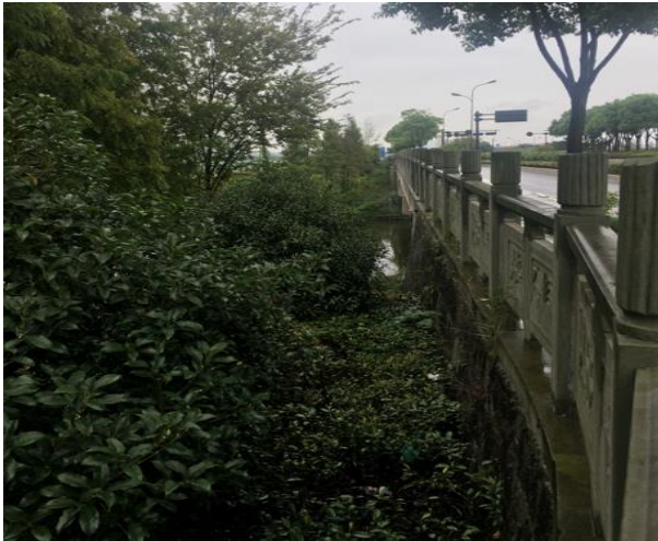
图 2-7 龙联村桥现状
