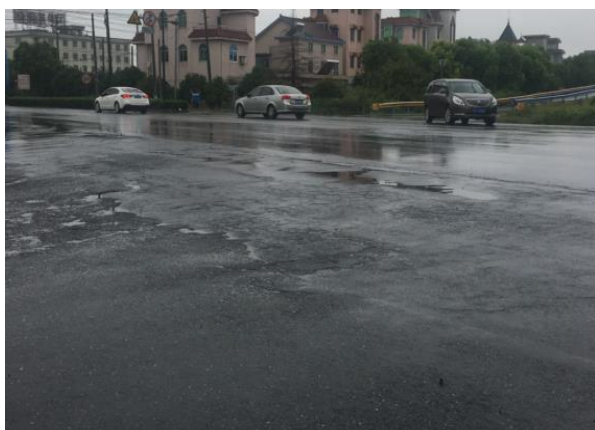
图 5 工程起点路面
