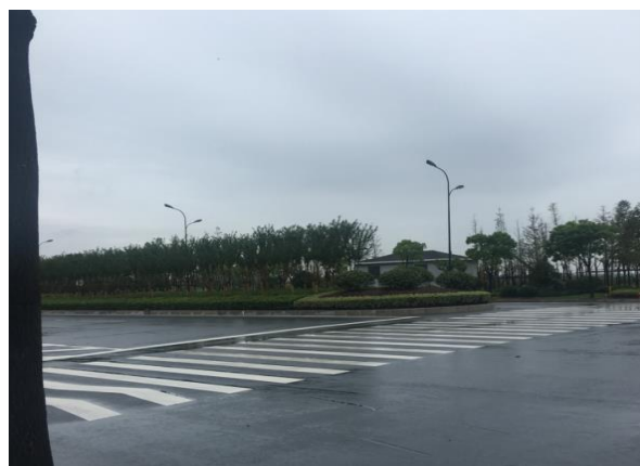
图 6 工程终点路面
