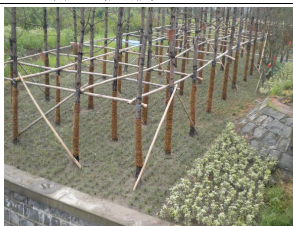
图 1-6 围垦沿塘河绿化施工（2011.12）
