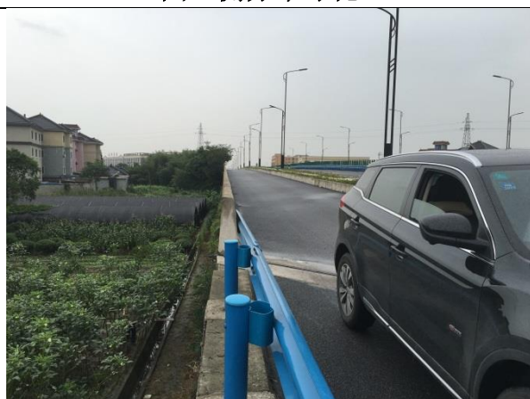
图 6 路基外侧排水沟
