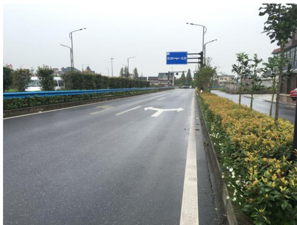
图4-2 植被建设工程-线网状植被
