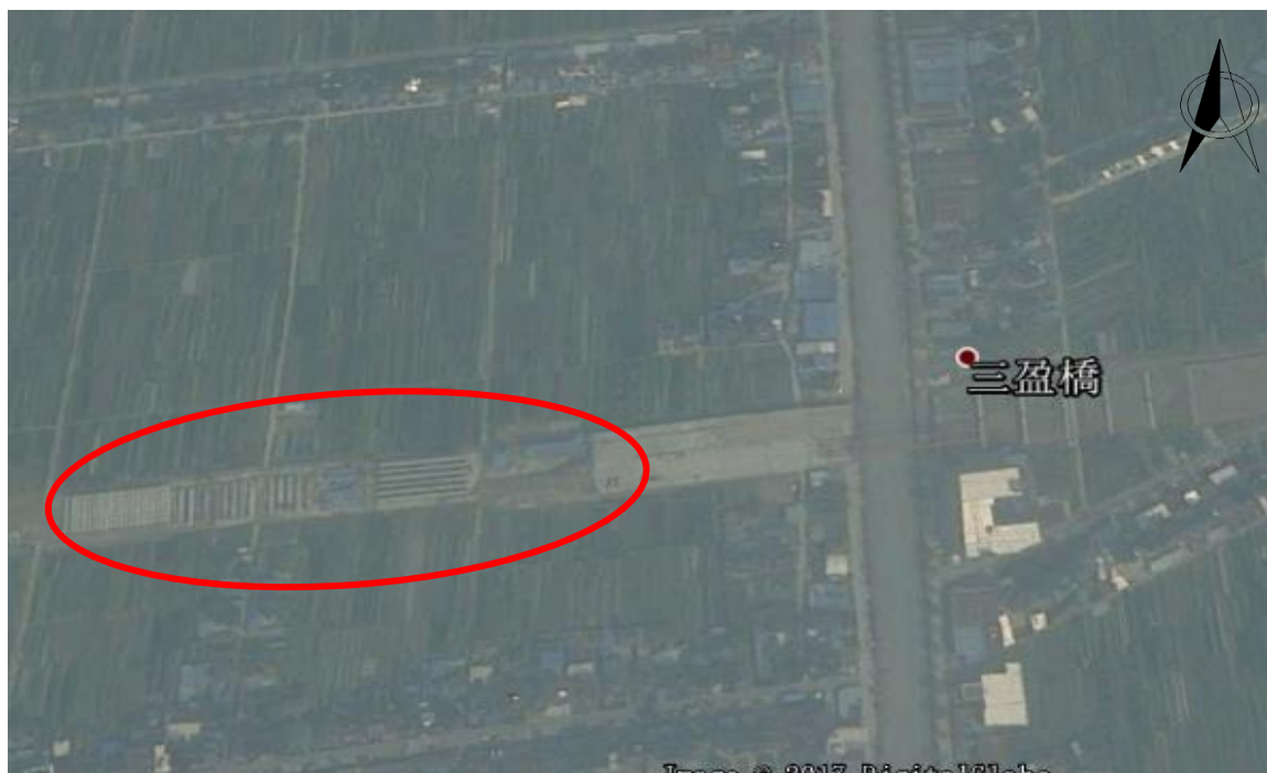
图 1-2 施工场地位置 (路基上 2)
