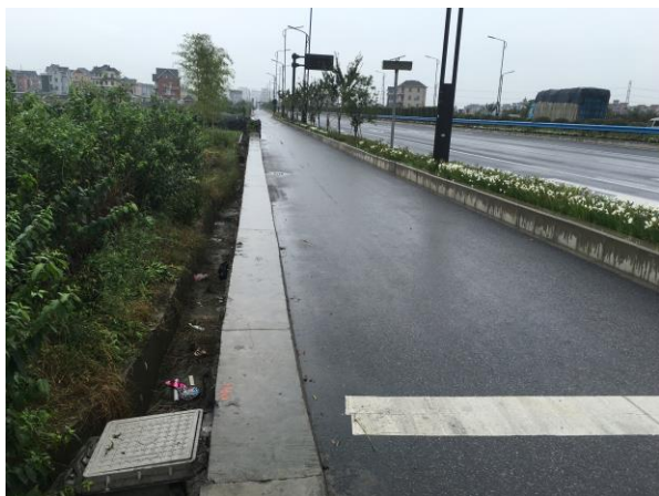
图4-1 防洪排导工程-排洪导流设施
